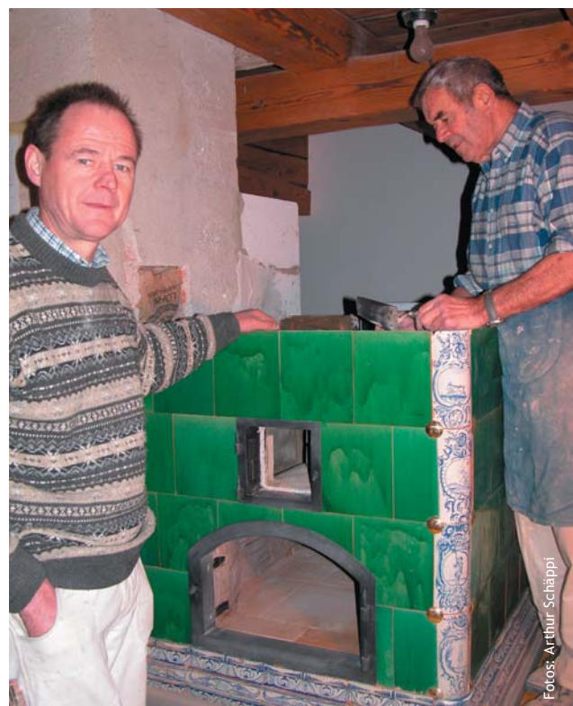
Mitte Dezember hatte Max Nydegger (rechts) den prächtigen Kachelofen für André Greil bereits bis auf Brusthöhe aufgemauert
